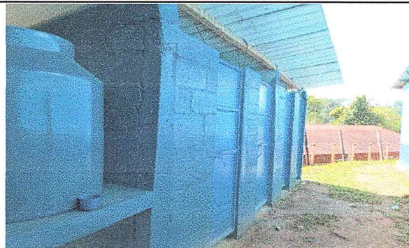
FOTO 2: CAMBIO DE PUERTAS DE BAÑO.
