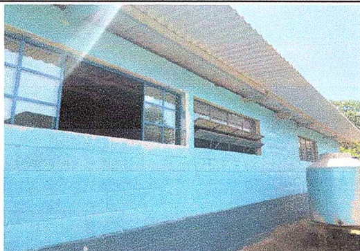
FOTO: PINTURA DE FACHADA.
