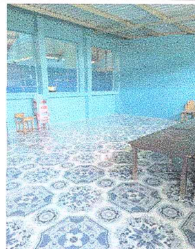
FOTO: PINTURA Y PISO CERAMICO.
